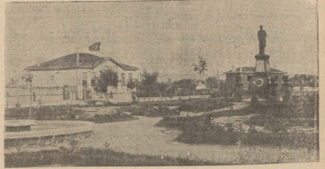
Trakyanın İnce köyünde park, anıt ve köy odası.
